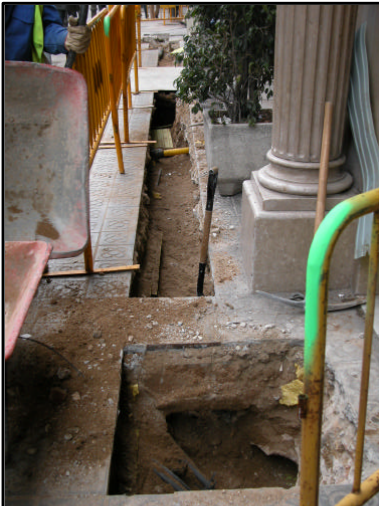
FOTOGRAFIA 6. Vista General de la Rasa 100
