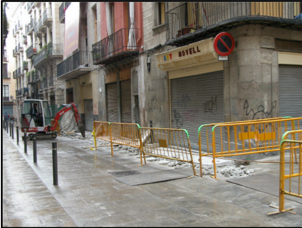
FOTOGRAFIA 17. Treballs d'obertura mecànics amb retroexcavadora de la Rasa 500
