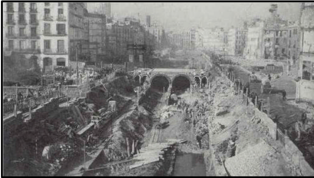
FOTOGRAFIA 5. Vista de l'obertura de la Via Laietana durant les obres de construcció de la línia 4 del metro de Barcelona (Museu d'Història de la Ciutat de Barcelona).
