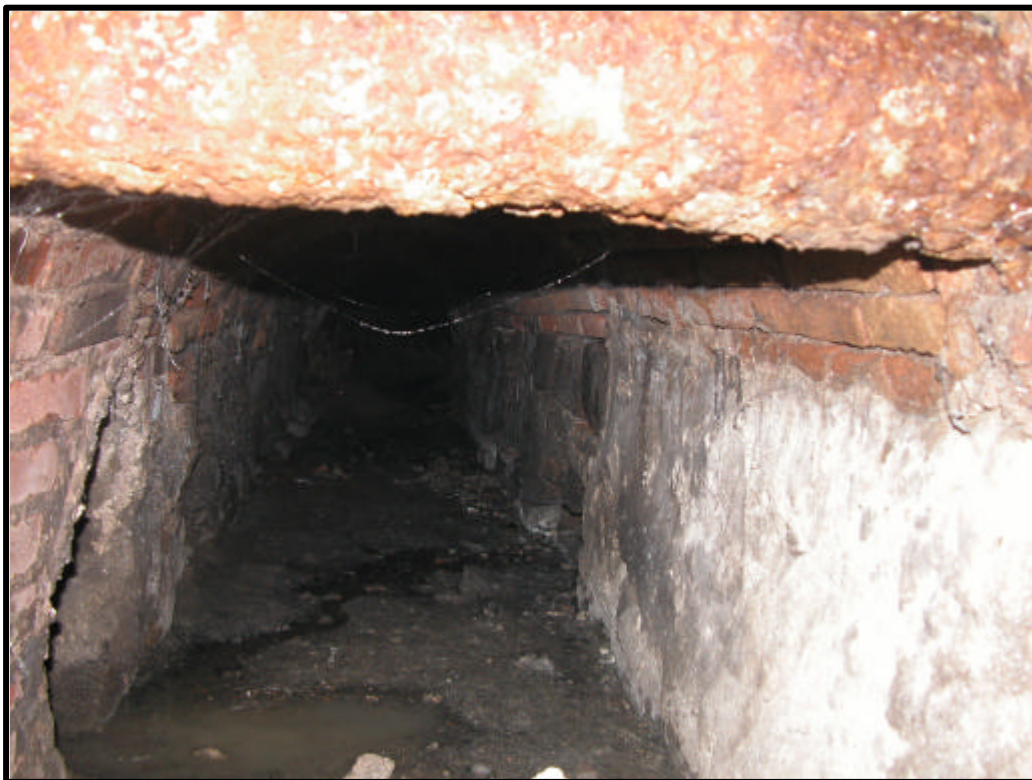
FOTOGRAFIA 14. Vista interior de la claveguera (UE 404) apareguda a la Rasa 400 (direcció SW).
