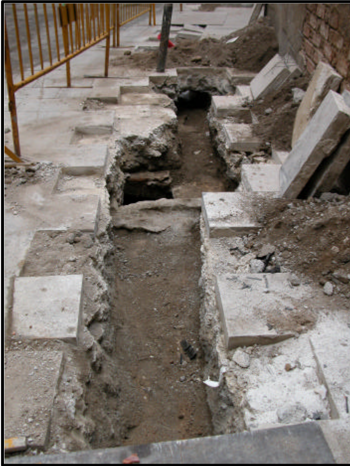
FOTOGRAFIA 11. Vista general de la Rasa 400.
