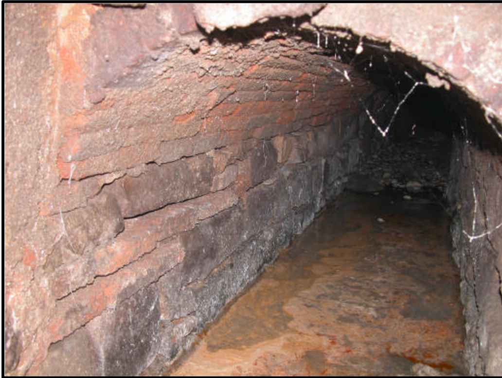
FOTOGRAFIA 13. Vista interior de la claveguera (UE 404) apareguda a la Rasa 400 (direcció NE).
