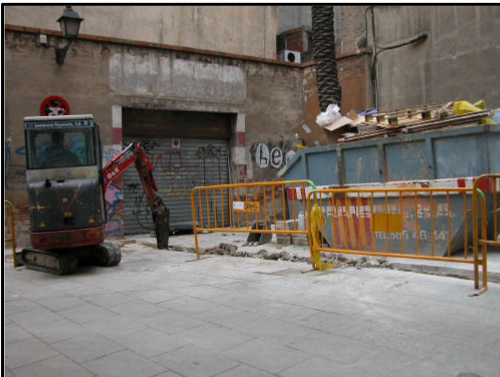
FOTOGRAFIA 10. Treballs d'obertura mecànics amb retroexcavadora de la Rasa 300.
