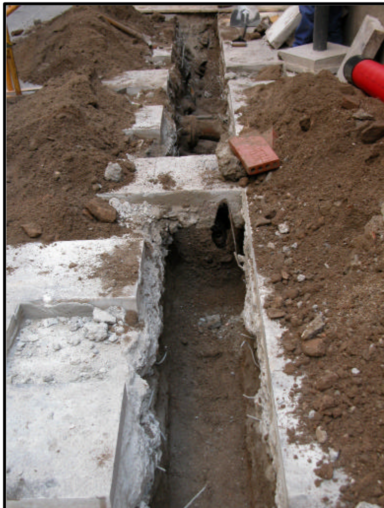
FOTOGRAFIA 17. Treballs d'obertura mecànics amb retroexcavadora de la Rasa 500
